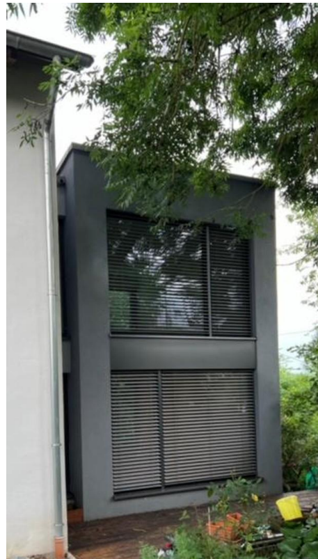
Anbau von hinten
