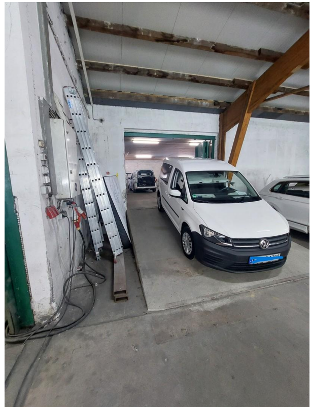
Rampe Halle1 zu Halle1 Anbau
