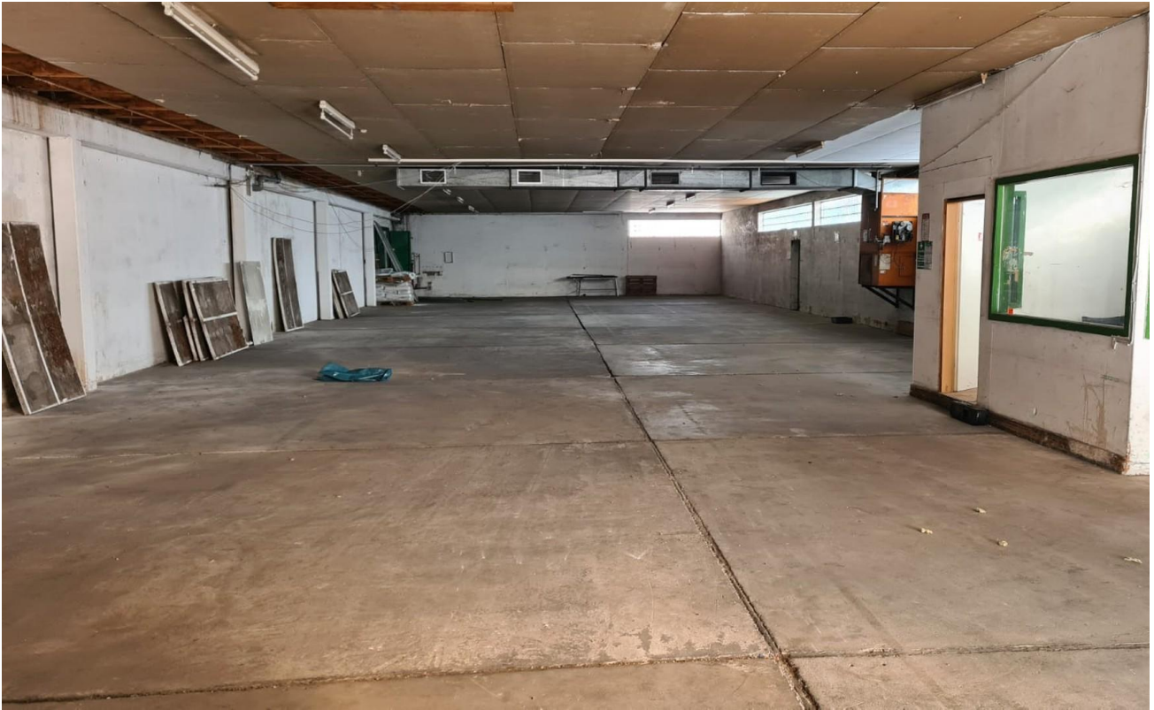
Anbau Halle 1 innen
