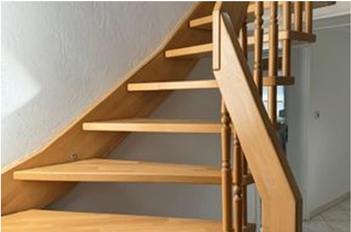
Treppe in 2. Etage
