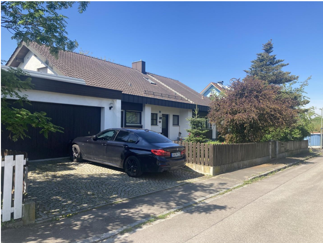
Nordseite / Garage / Eingang
