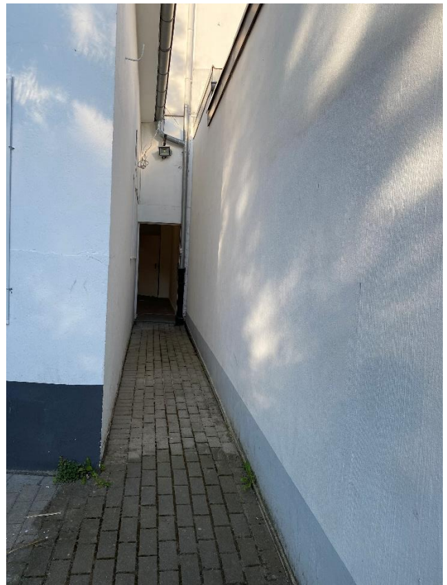
12. Abbildung: Hintereingang vom Parkplatz
