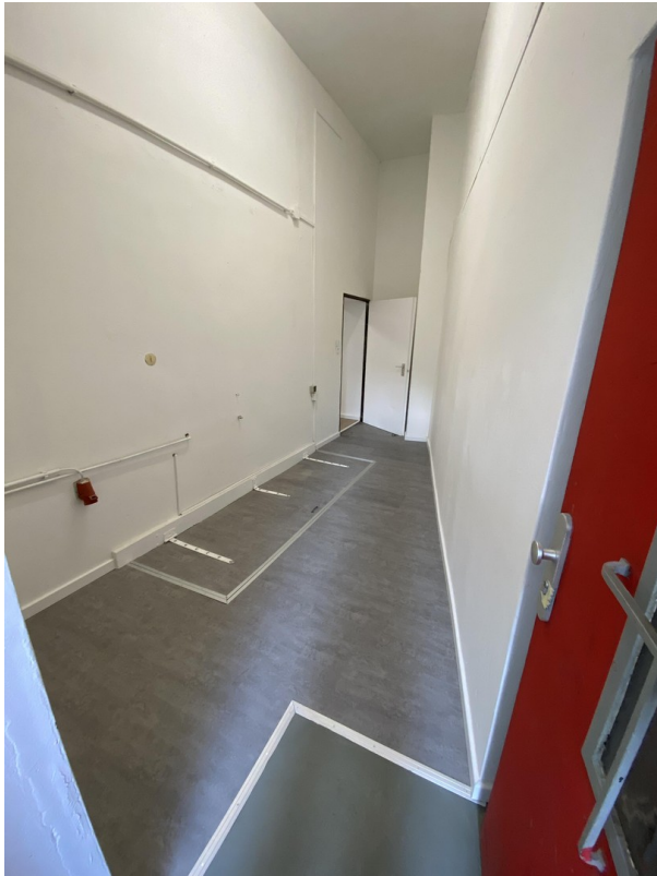
Hintereingang und Zugang Kelle
