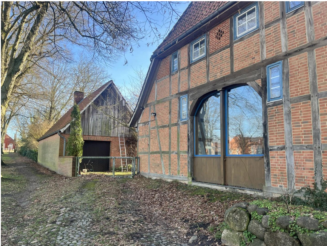
Haupthaus mit Nebengebäude Nr1
