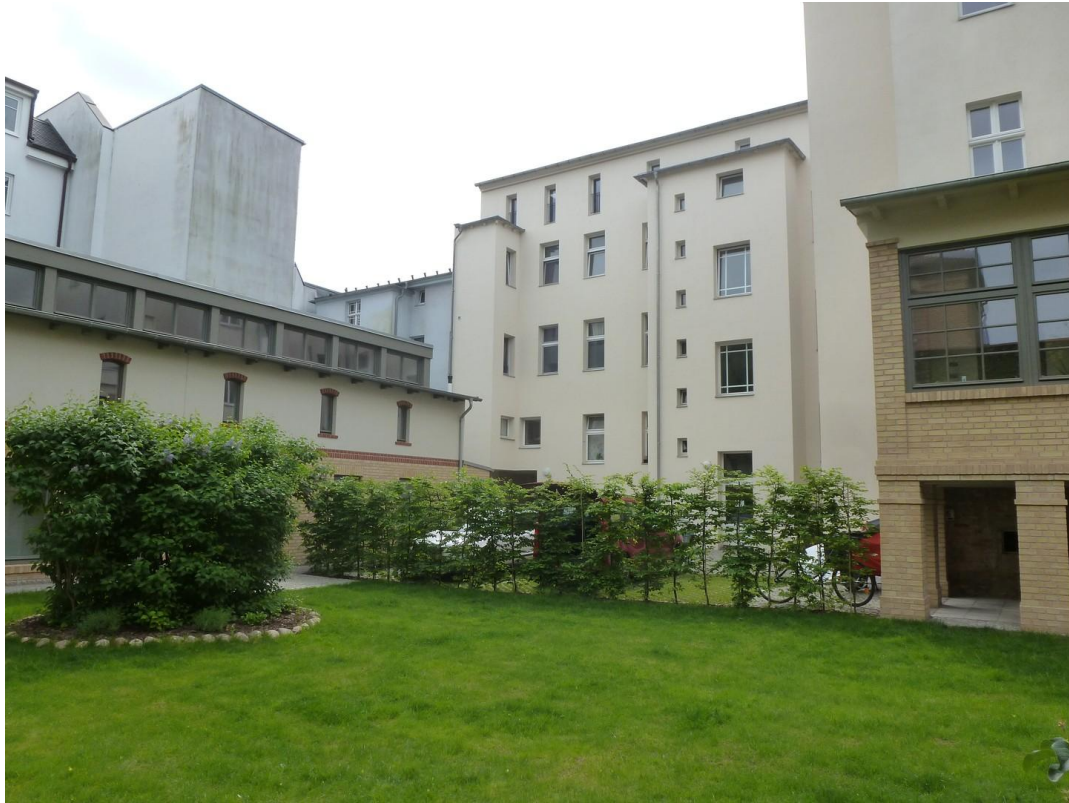
Blick auf Fassade hinten
