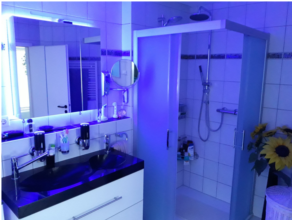
Badezimmer OG Hintergrundlicht
