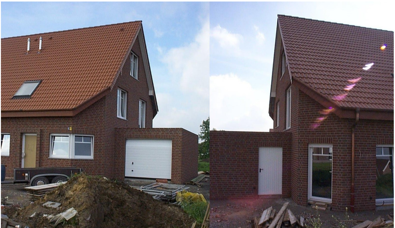
Bauphase im Jahr 2000
