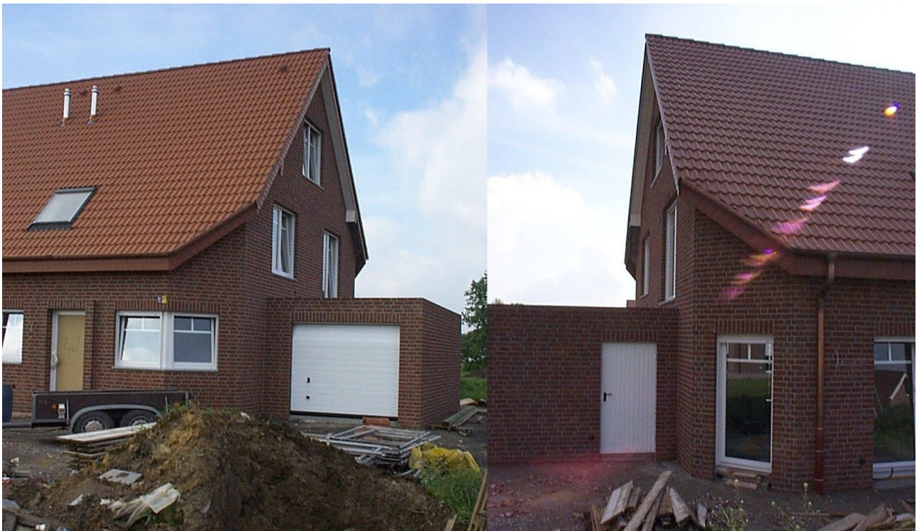
Bauphase im Jahr 2000
