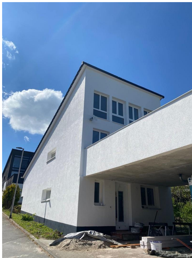
Nordansicht mit Zugang/Carport
