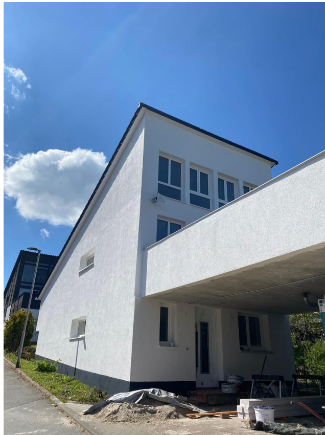
Nordansicht mit Zugang/Carport
