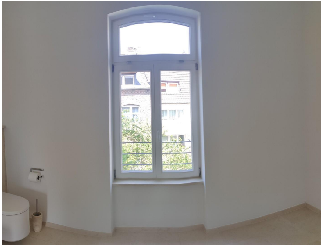
Fenster im Bad
