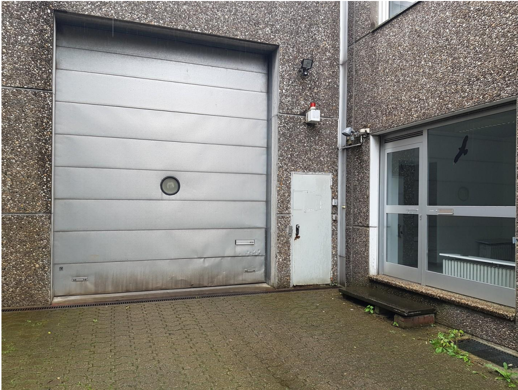
Zugang Büro und Tor zur Halle
