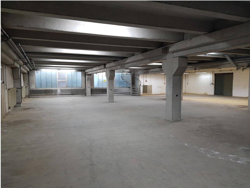
Zusätzliche Halle Untergeschoß
