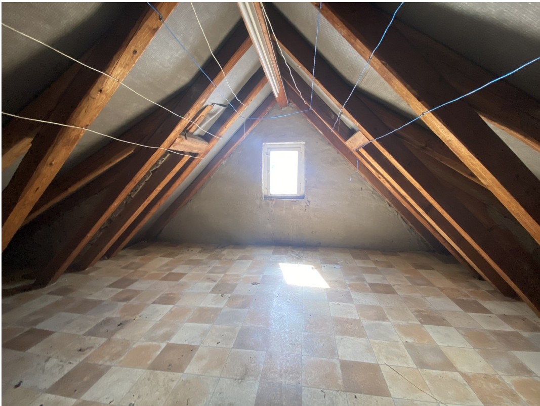
DHH 2 OG - Dachboden
