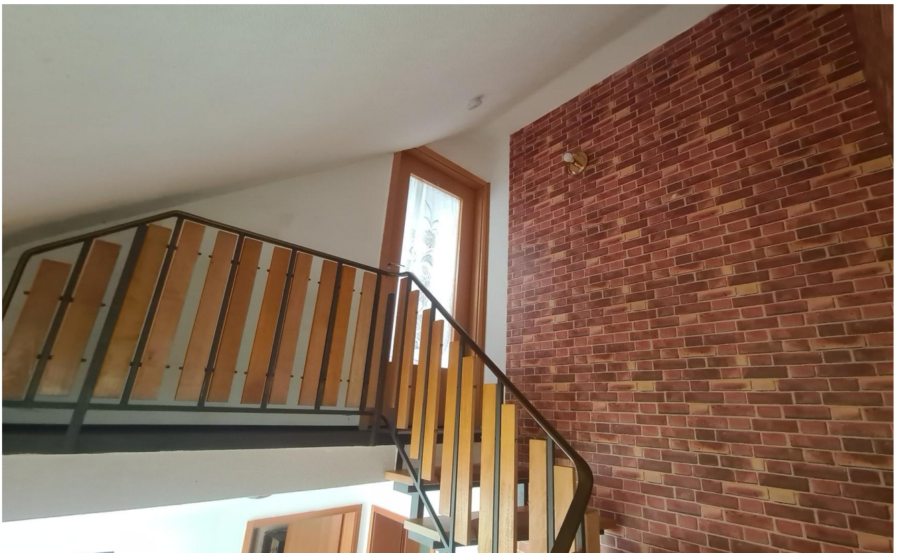
Treppenhaus Blick zum DG
