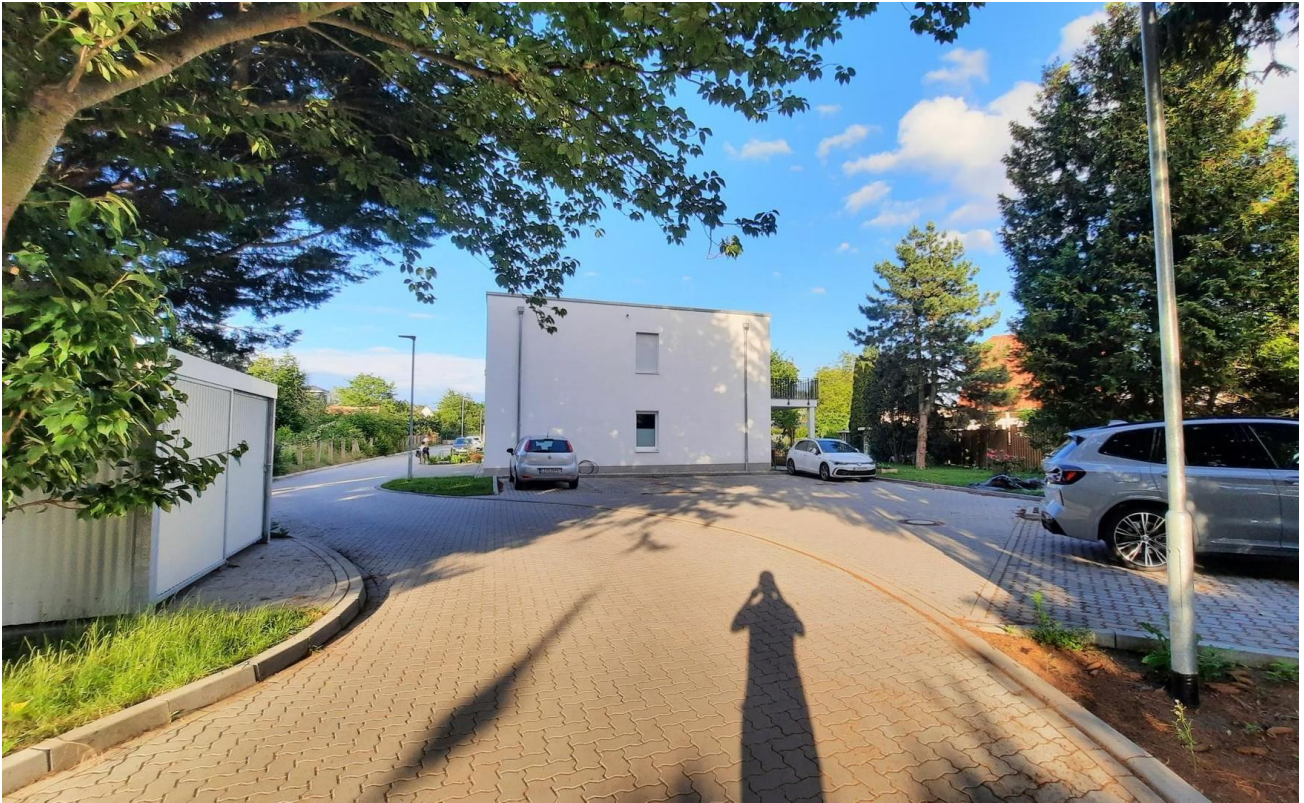
Westansicht mit Parkplatz re
