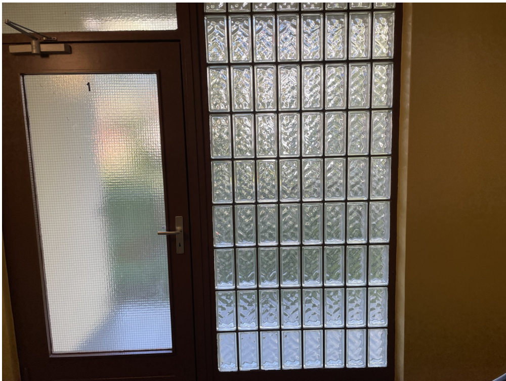
Treppenhaus zu Laubengang
