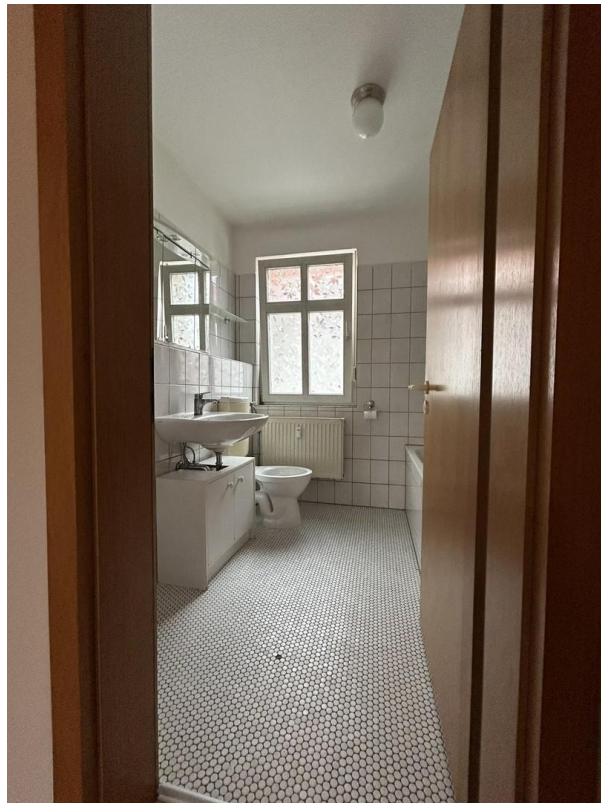
Bad wird renoviert
