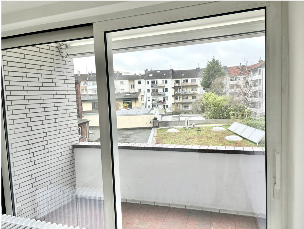
Blick auf die Dachbegrünung
