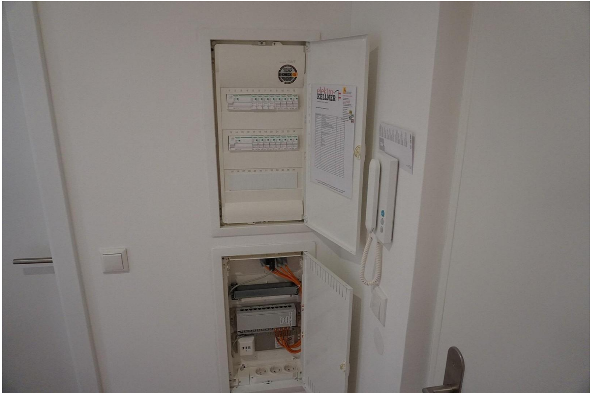
neue Installation ELT u. LAN
