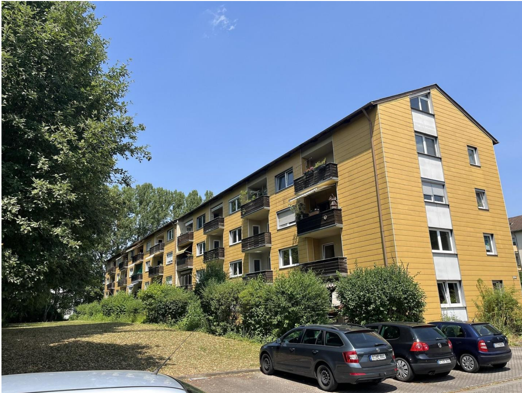
Rückseite Balkon Richtung SW
