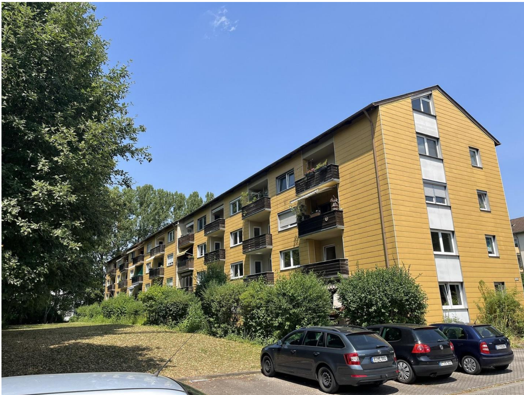
Rückseite Balkon Richtung SW
