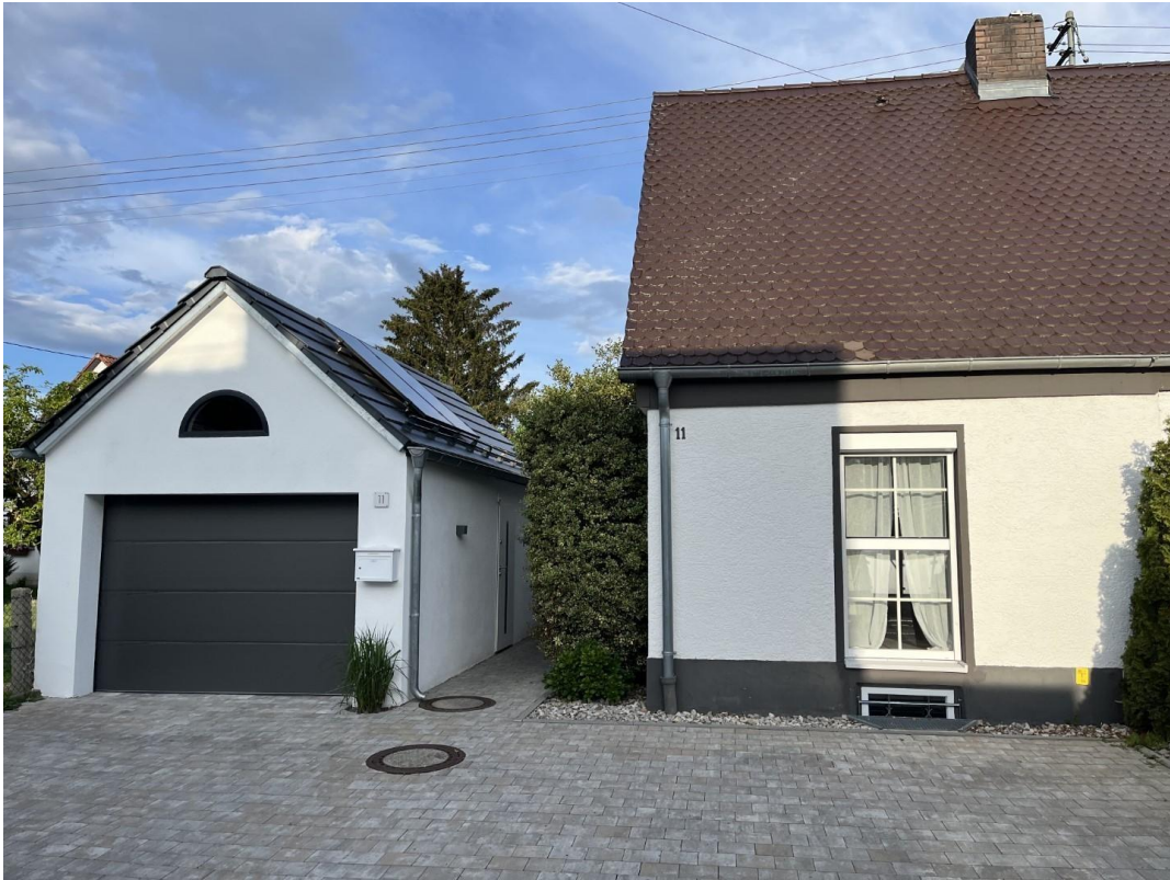
Frontansicht Wohnhaus / Garage
