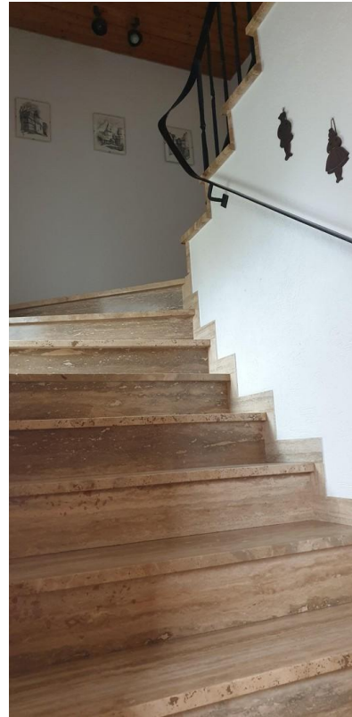
Treppe zum 1. OG
