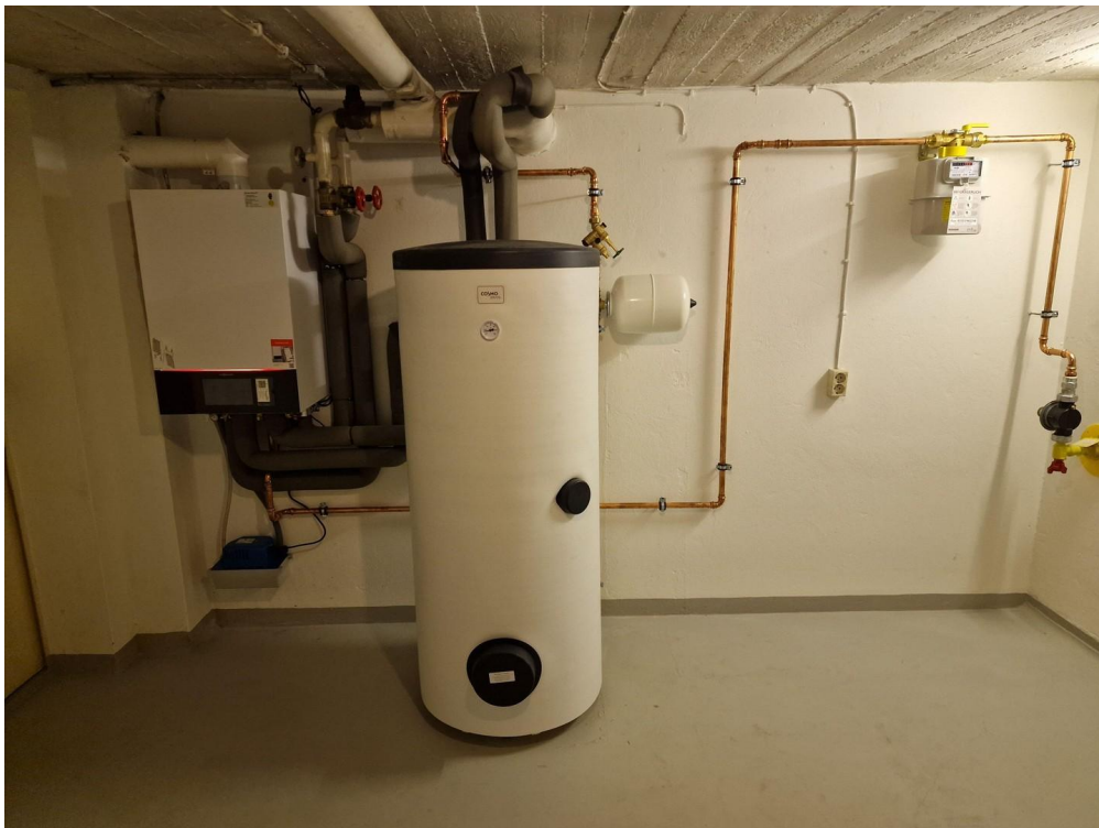
Neue Gas-Brennwerttherme
