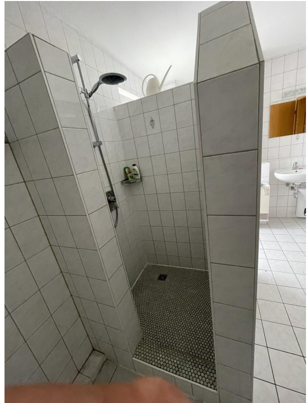
begehbare Dusche (gefliest)
