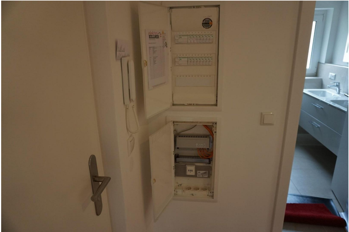
neue Installation ELT u. LAN
