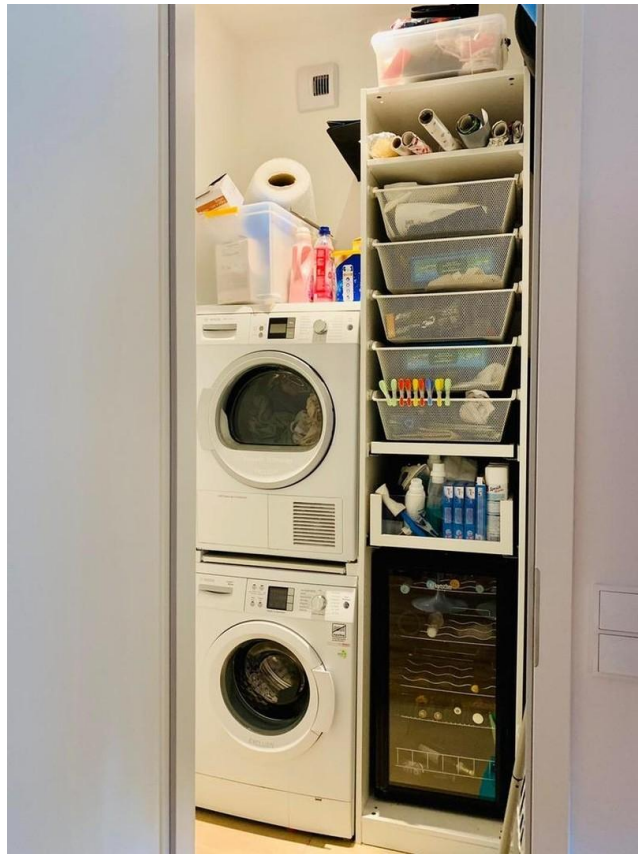
Abstellraum mit WM + Trockner
