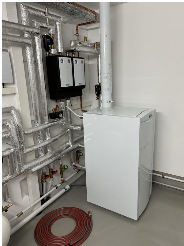
Vaillant Gastherme 26 KW
