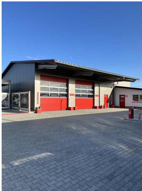
Westansicht Werkstatt und Büro
