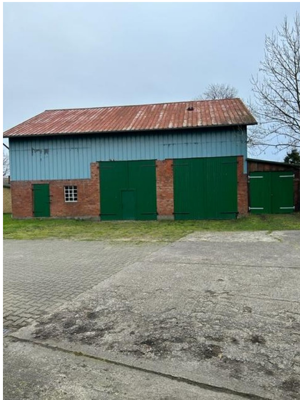
Schuppen und Garage
