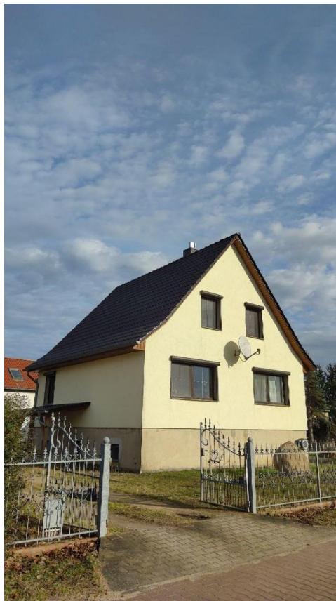
Außenansicht von SW
