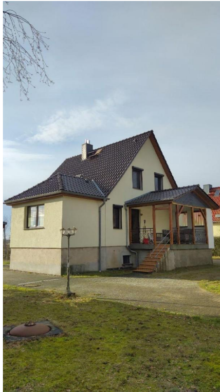
Außenansicht von NO
