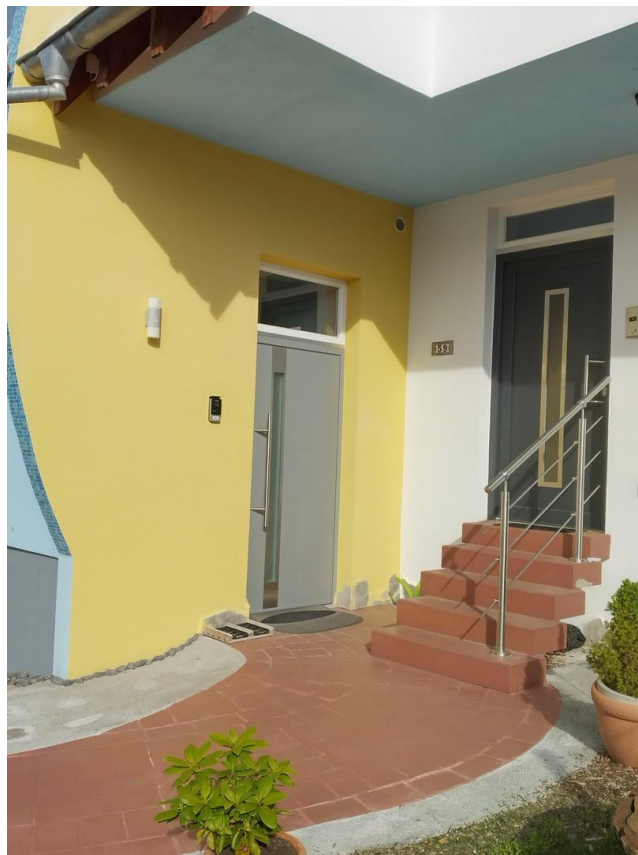
Eingänge ins Haus bzw. Apartm.
