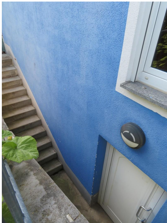
Zugang zum Keller
