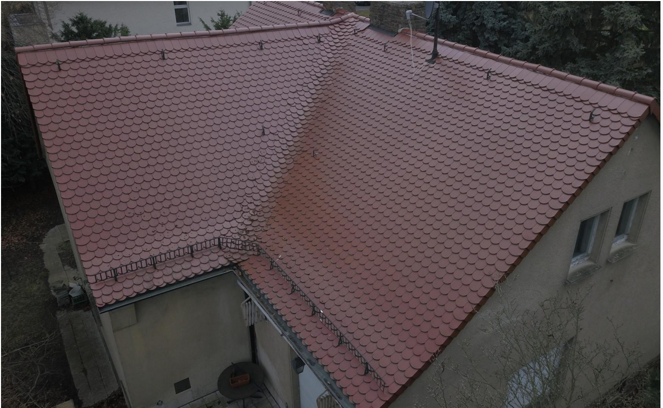
Laufaufnahme Zustand Dach
