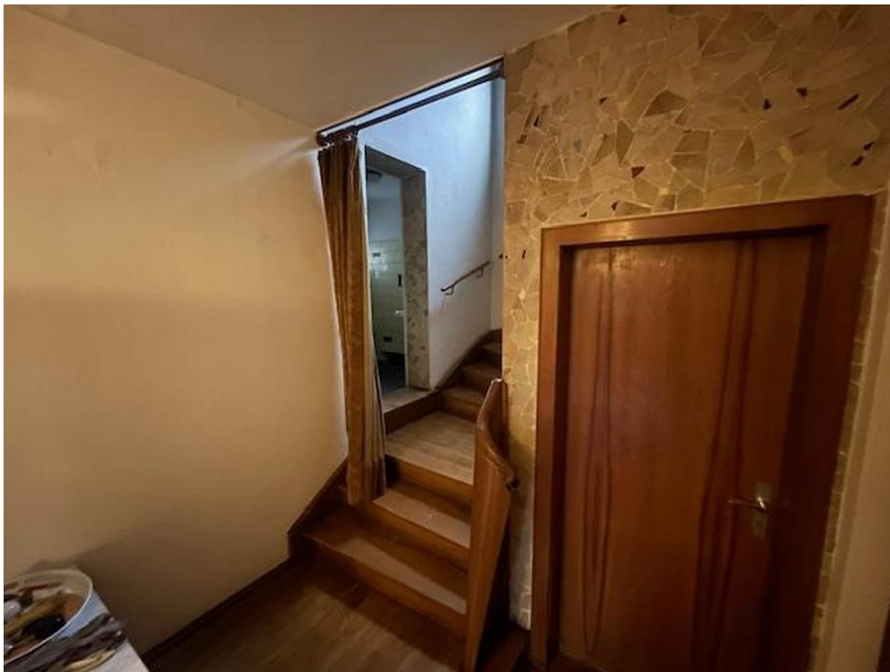
Treppenflur zum OG und Keller
