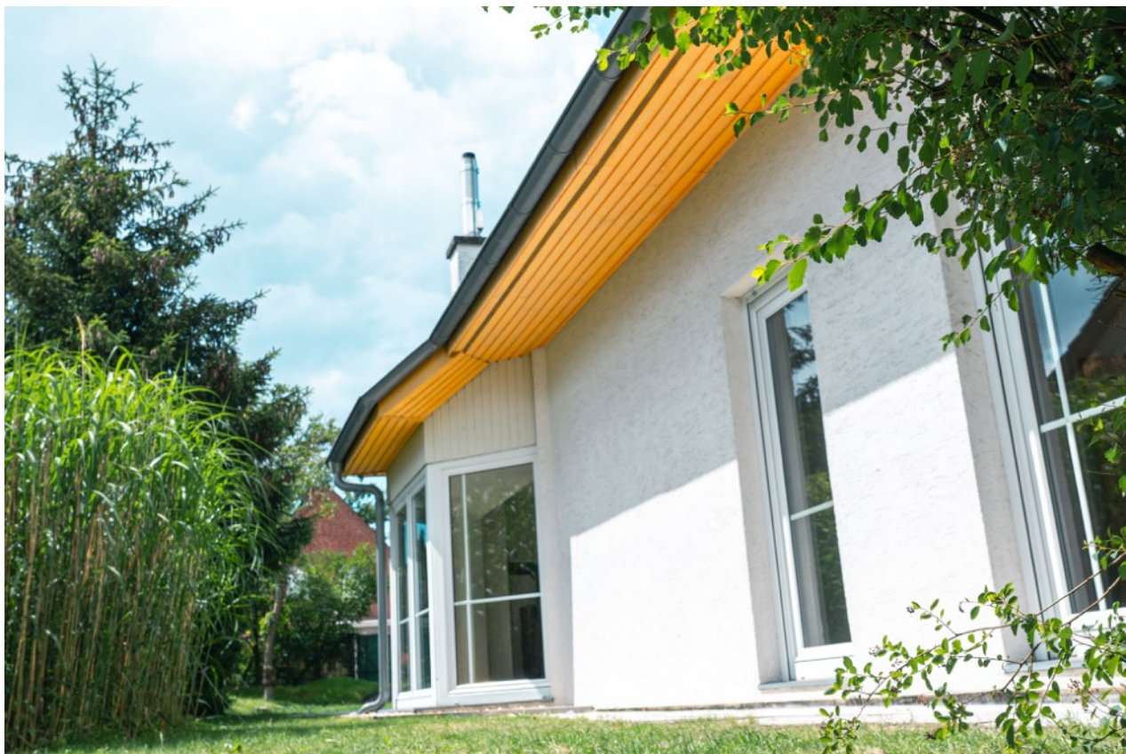
Rechte Hausseite mit dem Erker im Wohnzimmer
