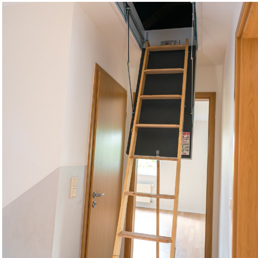
Treppe zum Dachboden
