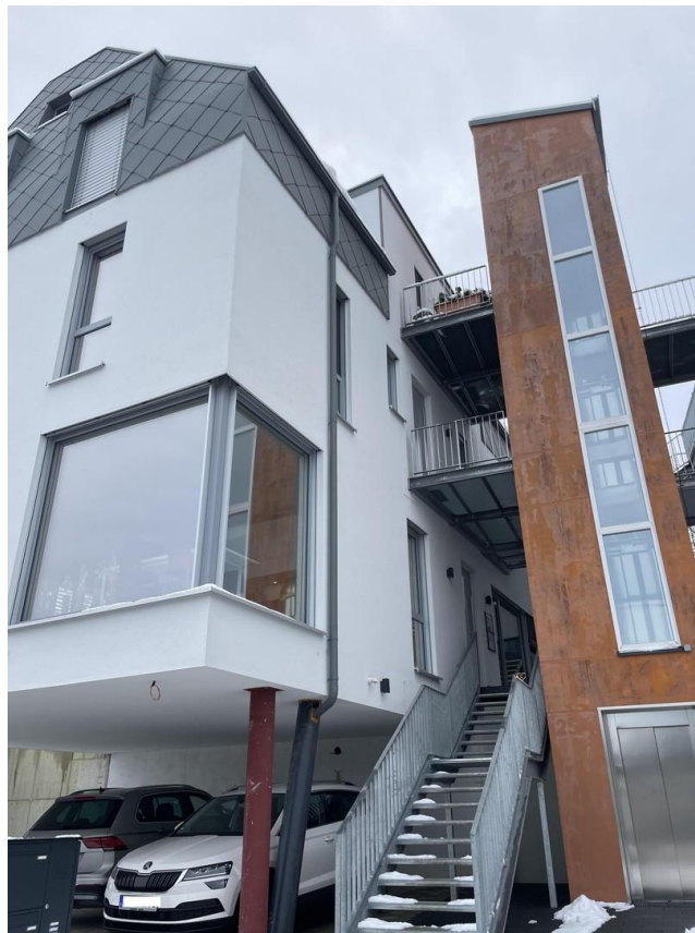
Außenansicht Blick auf Glaseck
