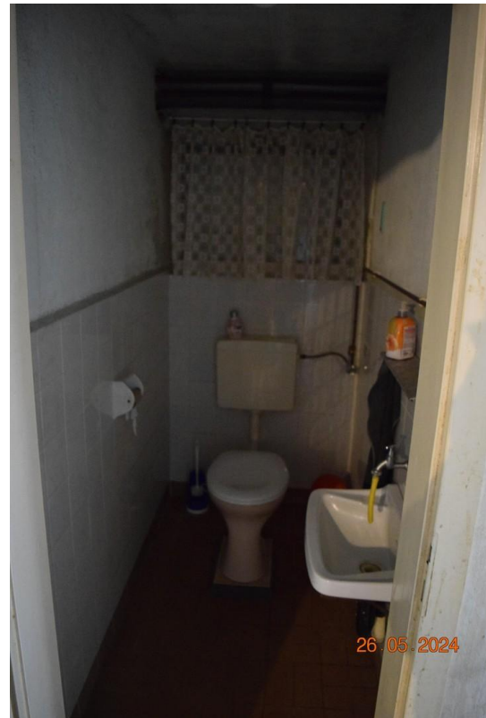
WC im Keller
