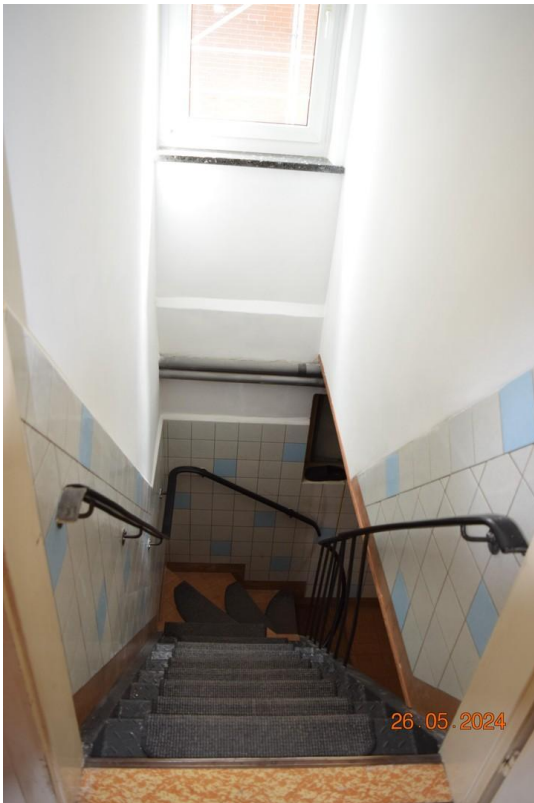
Keller Eingang vom EG
