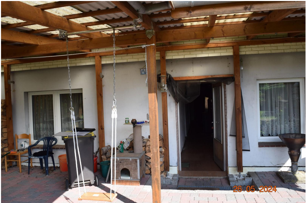
Terrasse mit Keller-Eingang
