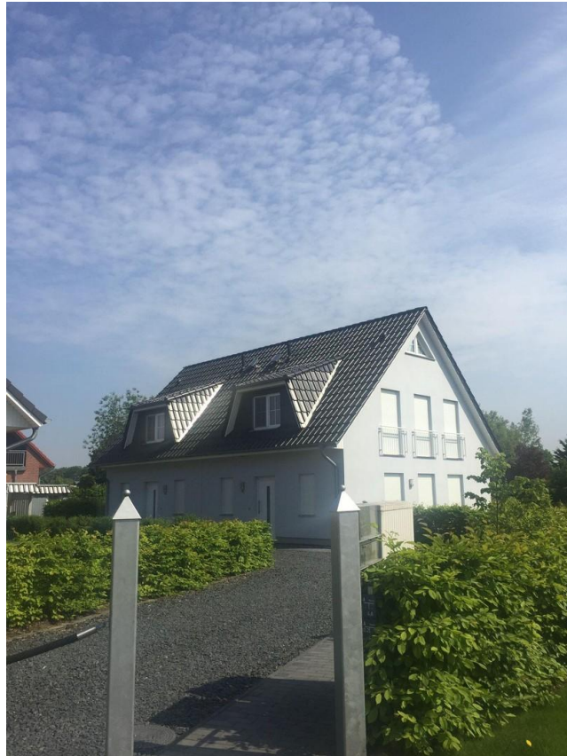
Zufahrt zur Doppelhaushälfte
