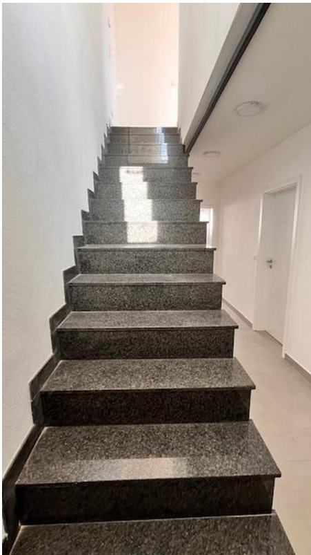
Treppe ins DG
