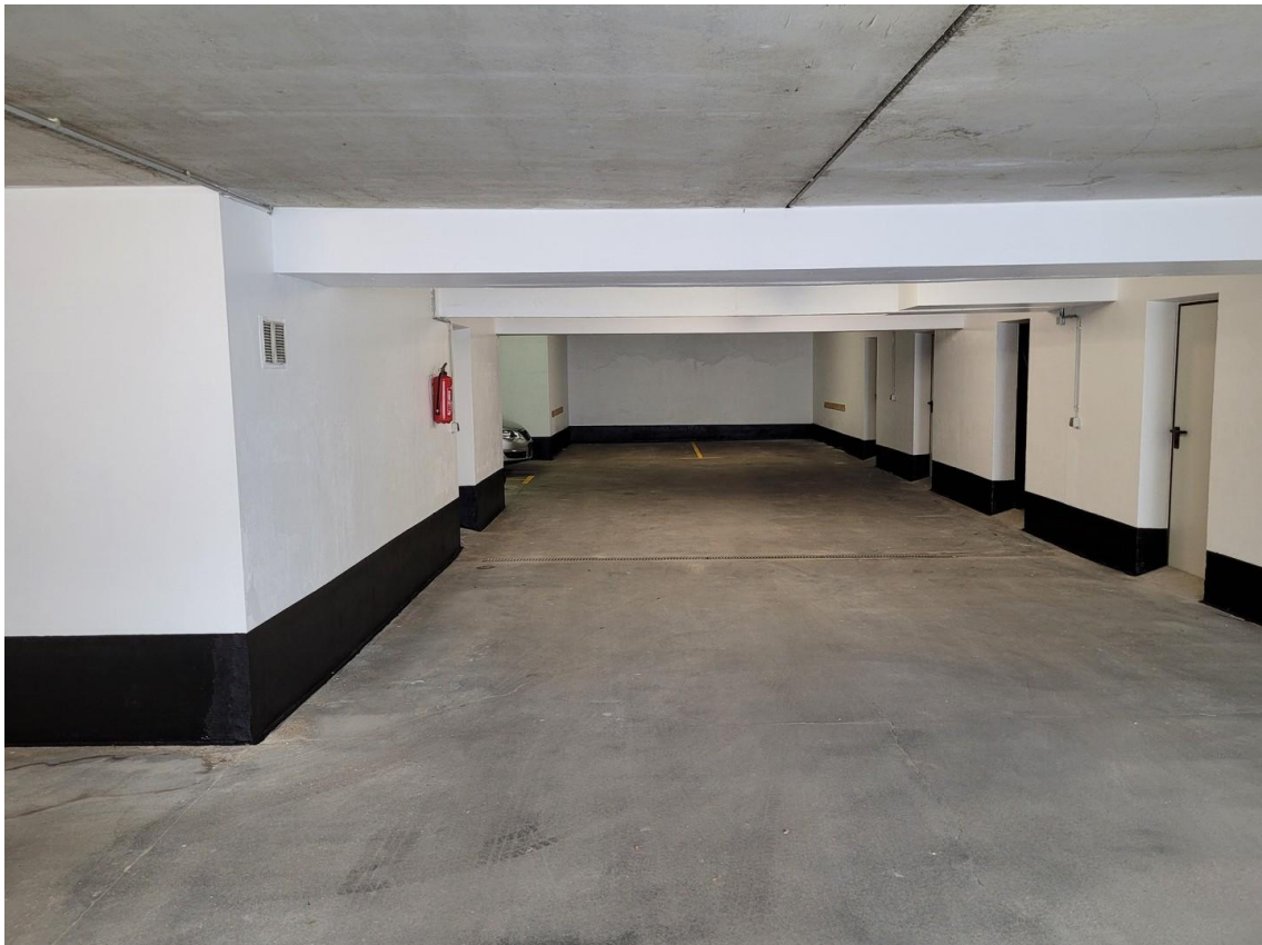
Tiefgarage mit Mieterkellern
