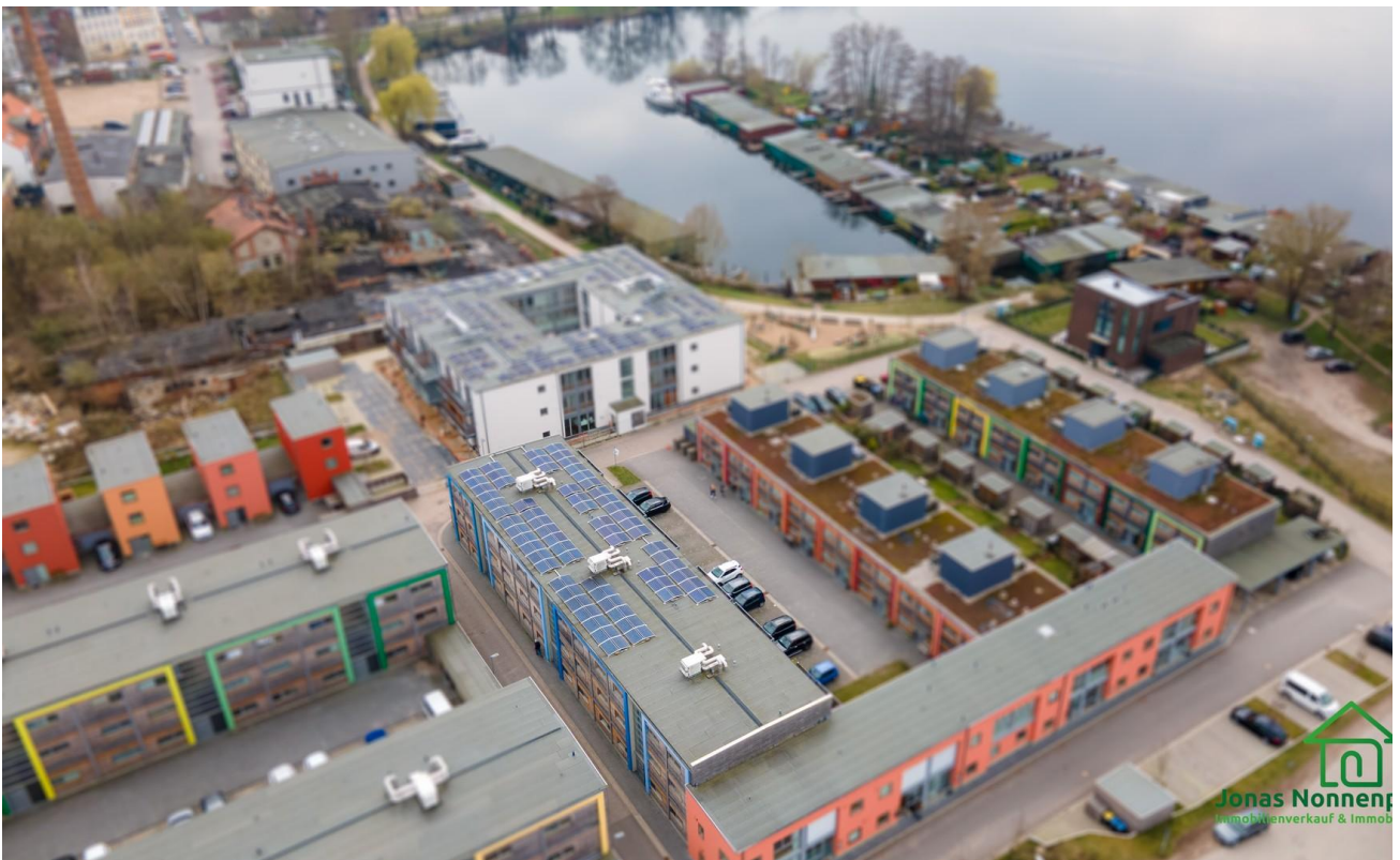
Ansicht nach Südwesten
