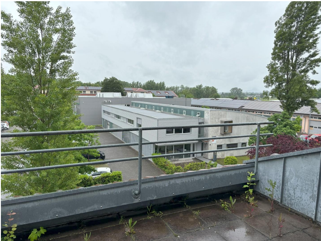
Balkon zu Bürofläche 2.OG
