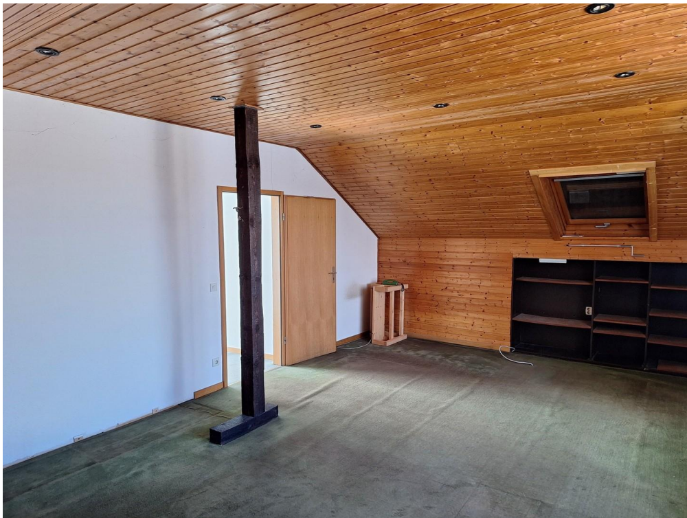
Raum im Dachgeschoss
