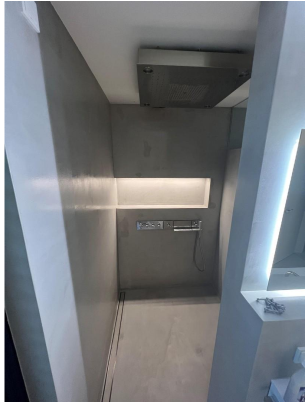
Hauptbad OG - Showerheaven
