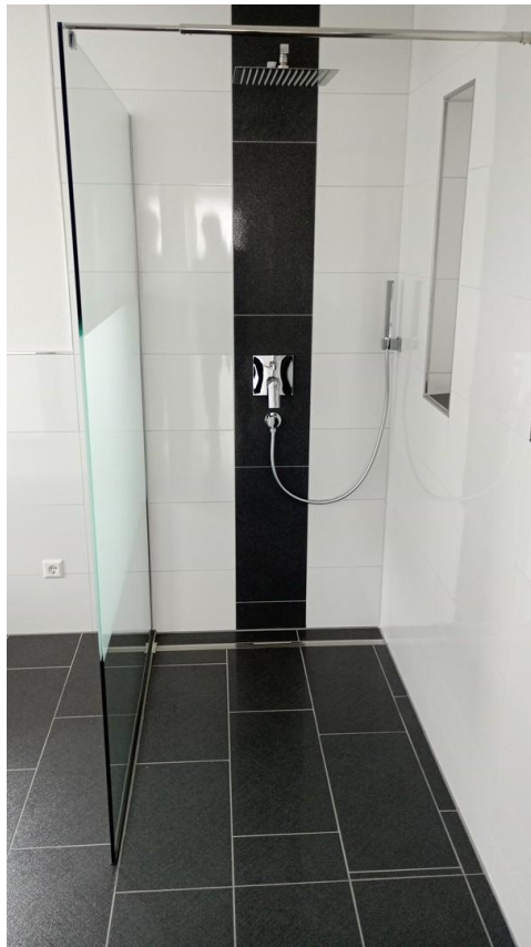
Begehbare Dusche Bad
