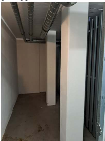
Kellerraum im 2. UG
