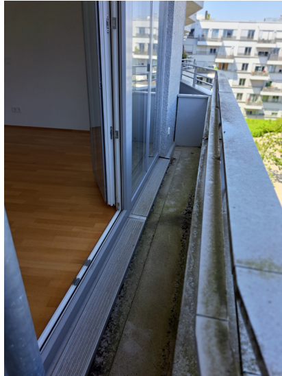
Austritt an Zimmern
