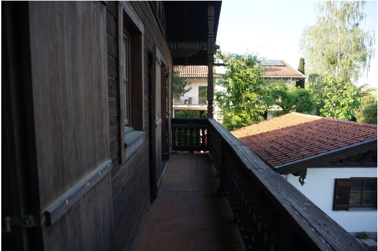
Balkon Ostseite 1. OG
