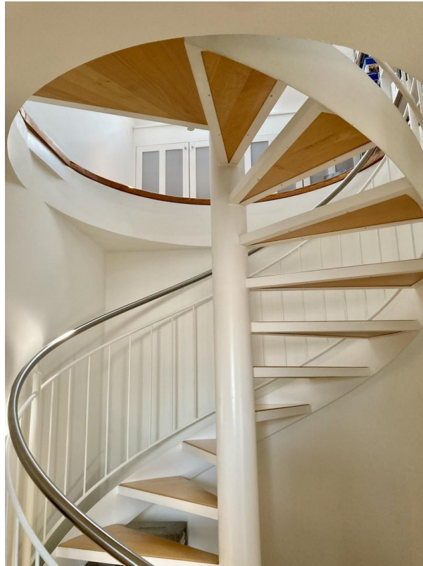
Treppenaufgang ins OG
