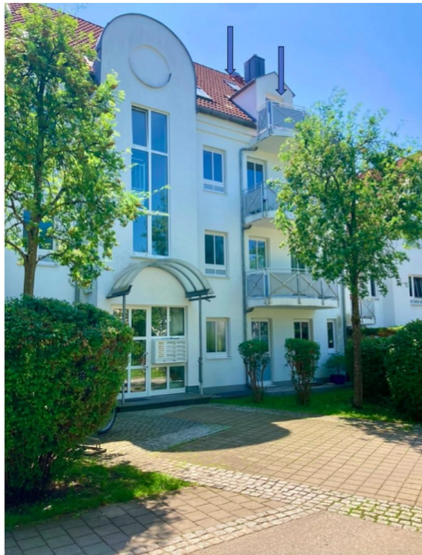
Eingang - Nordansicht Haus
