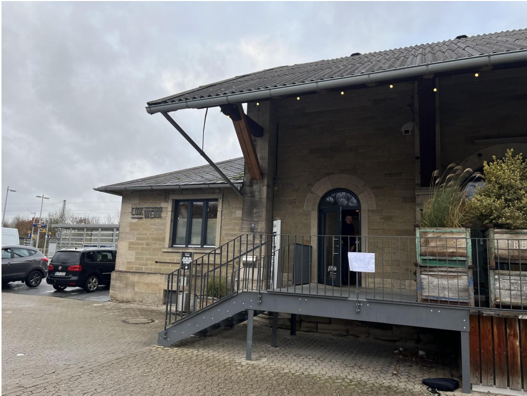
Eingangsbereich mit Treppe
