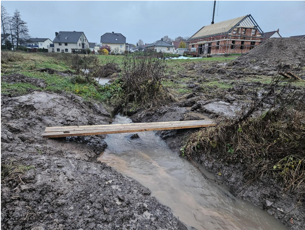
Standort Brücke Geh-und Radweg
