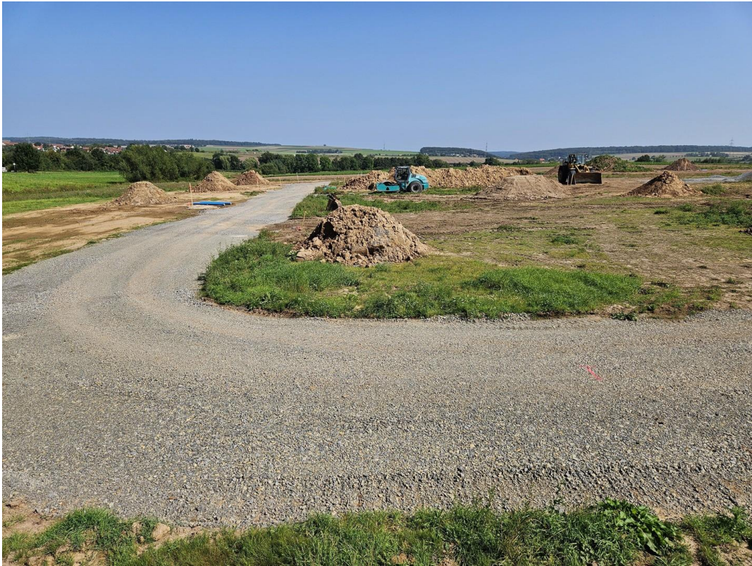
Bereich Flurstücke 663 bis 671
