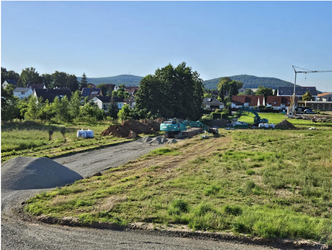
Kanalbau im Westen
