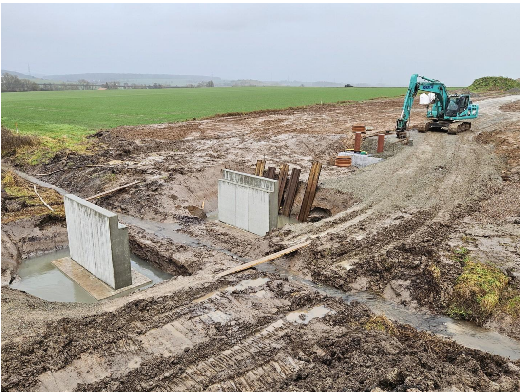
Brückenfundamente Geh- & Radweg
