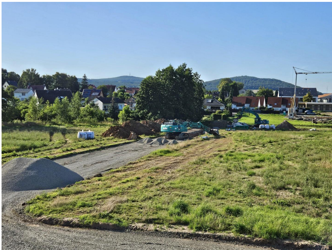
Kanalbau im Westen
