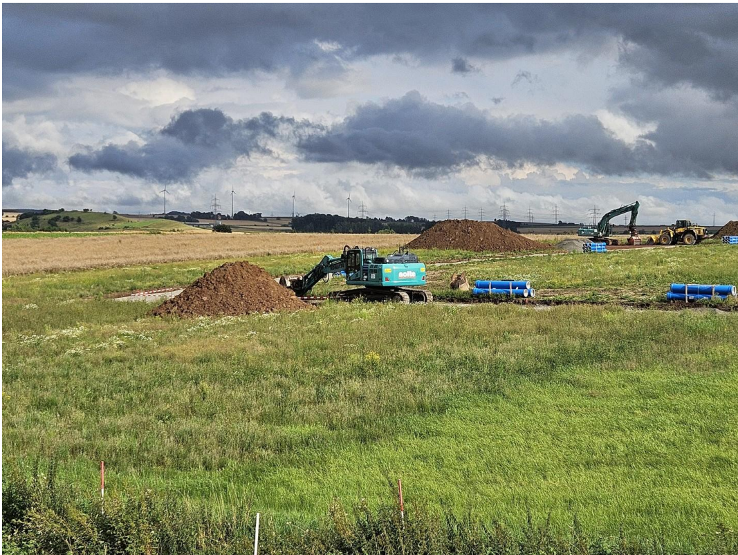
Kanalbau Richtung Südosten
