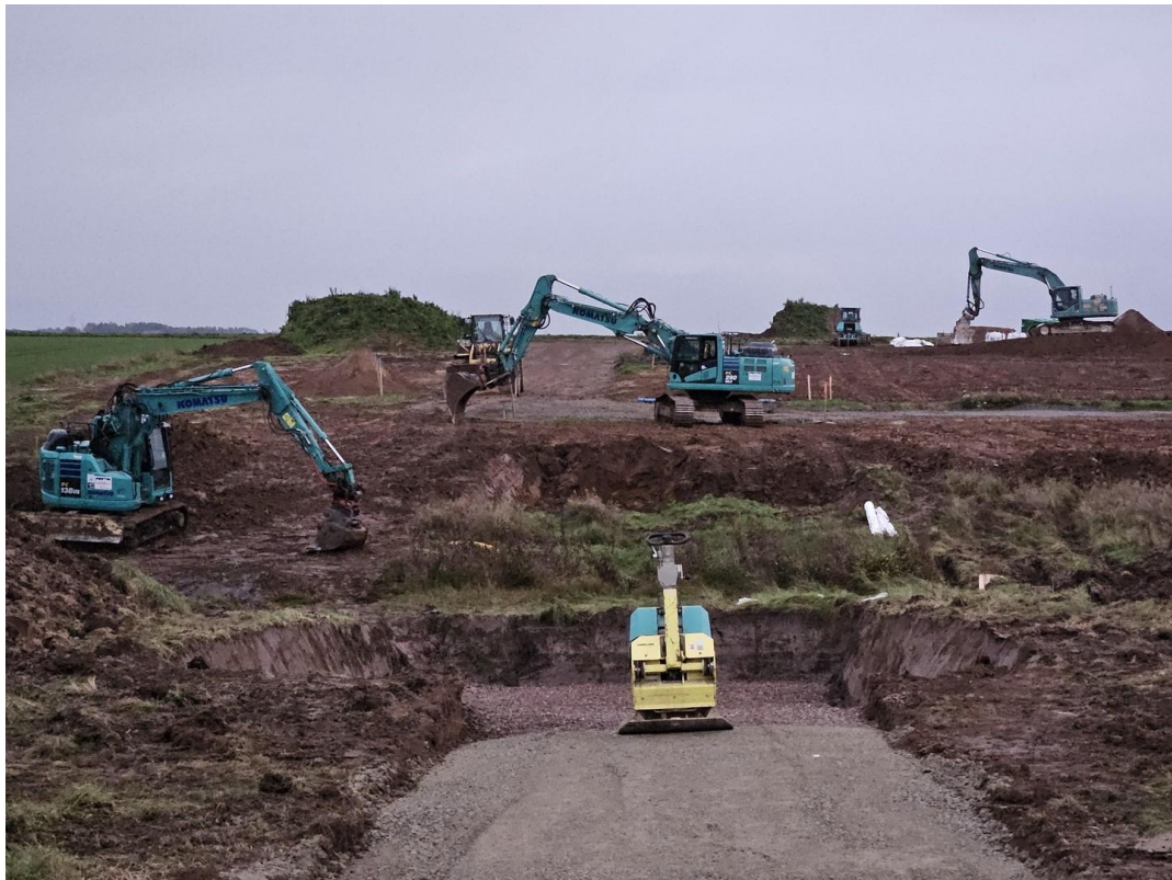
Bereich Rad- und Gehwegbrücke
