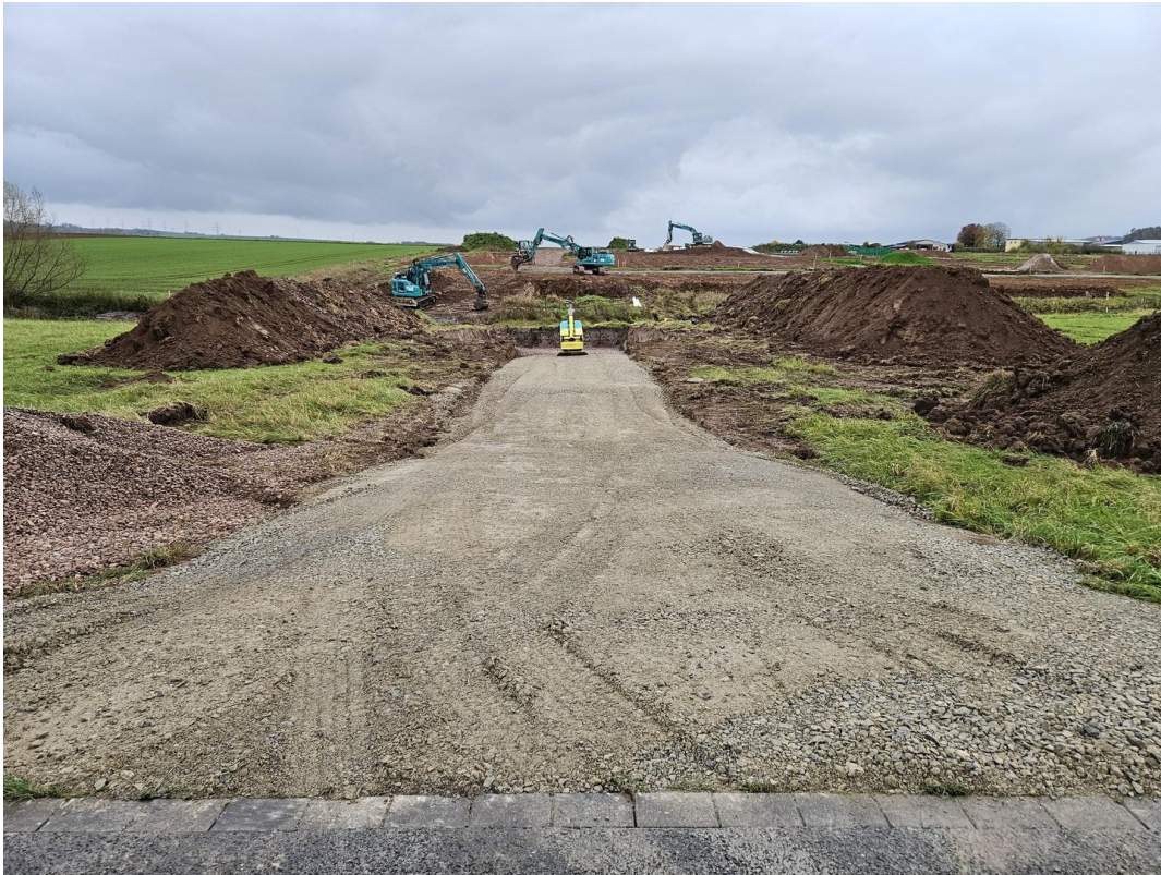
Verbindung Stettiner Strasse
