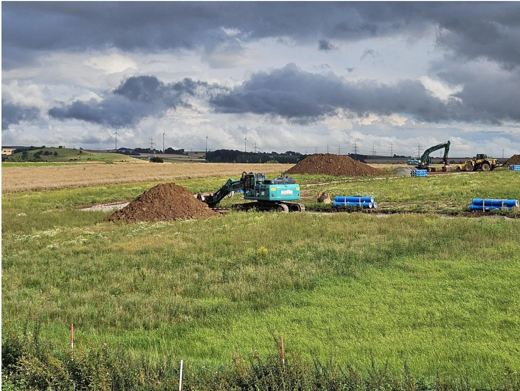
Kanalbau Richtung Südosten
