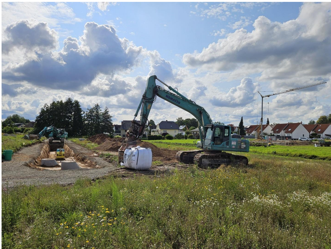
Kanalbau Richtung Westen
