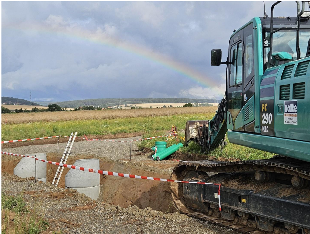
Kanalbau unter dem Regenbogen
