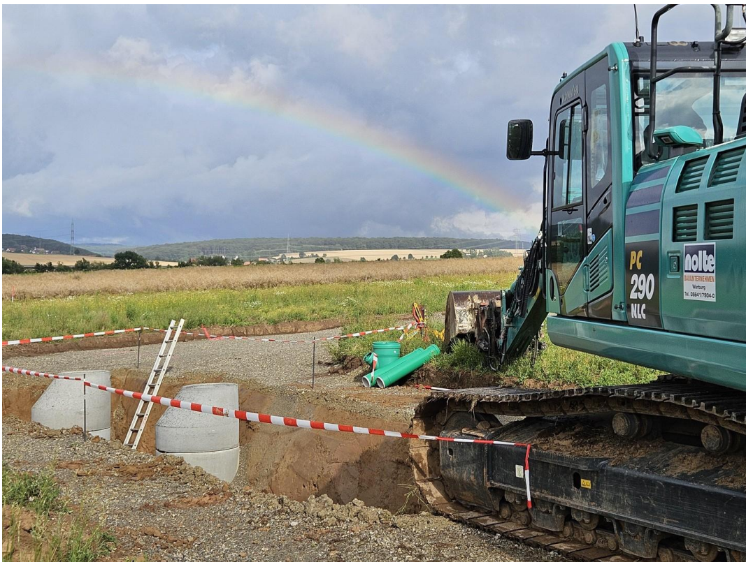
Kanalbau unter dem Regenbogen
