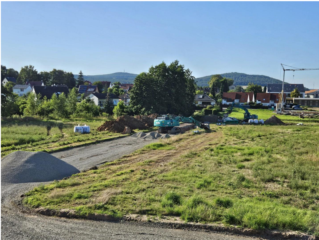
Kanalbau im Westen
