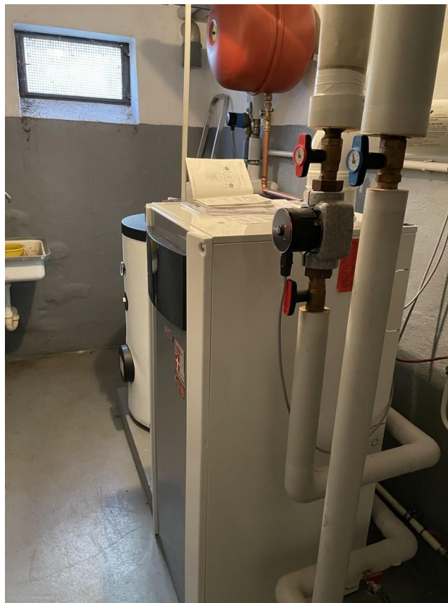
Öl Brennwertkessel
