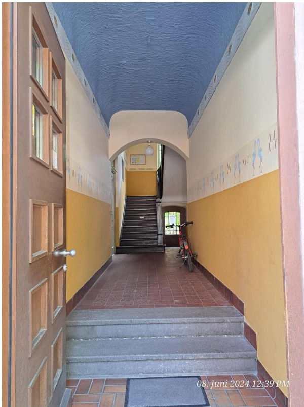
Flur ins Treppenhaus
