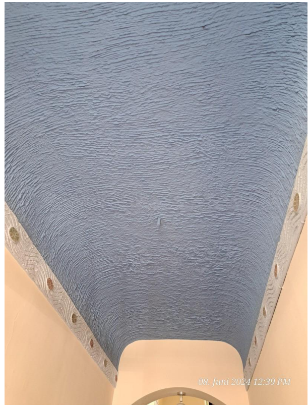
Flur ins Treppenhaus
