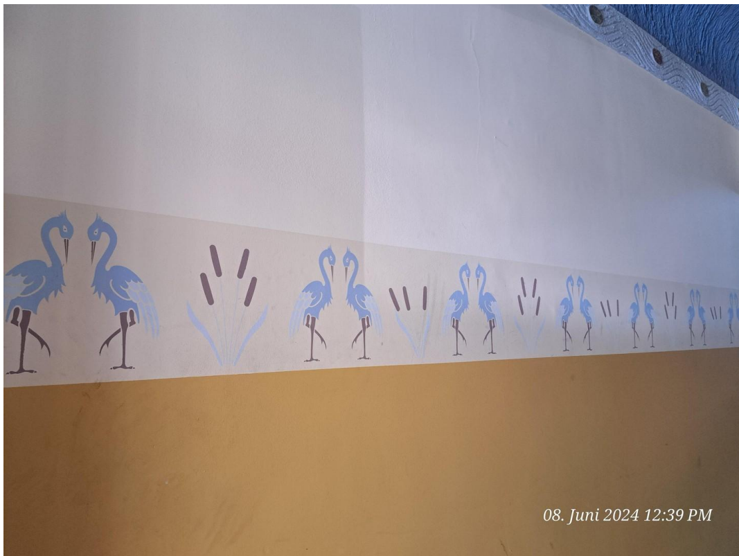
Flur ins Treppenhaus
