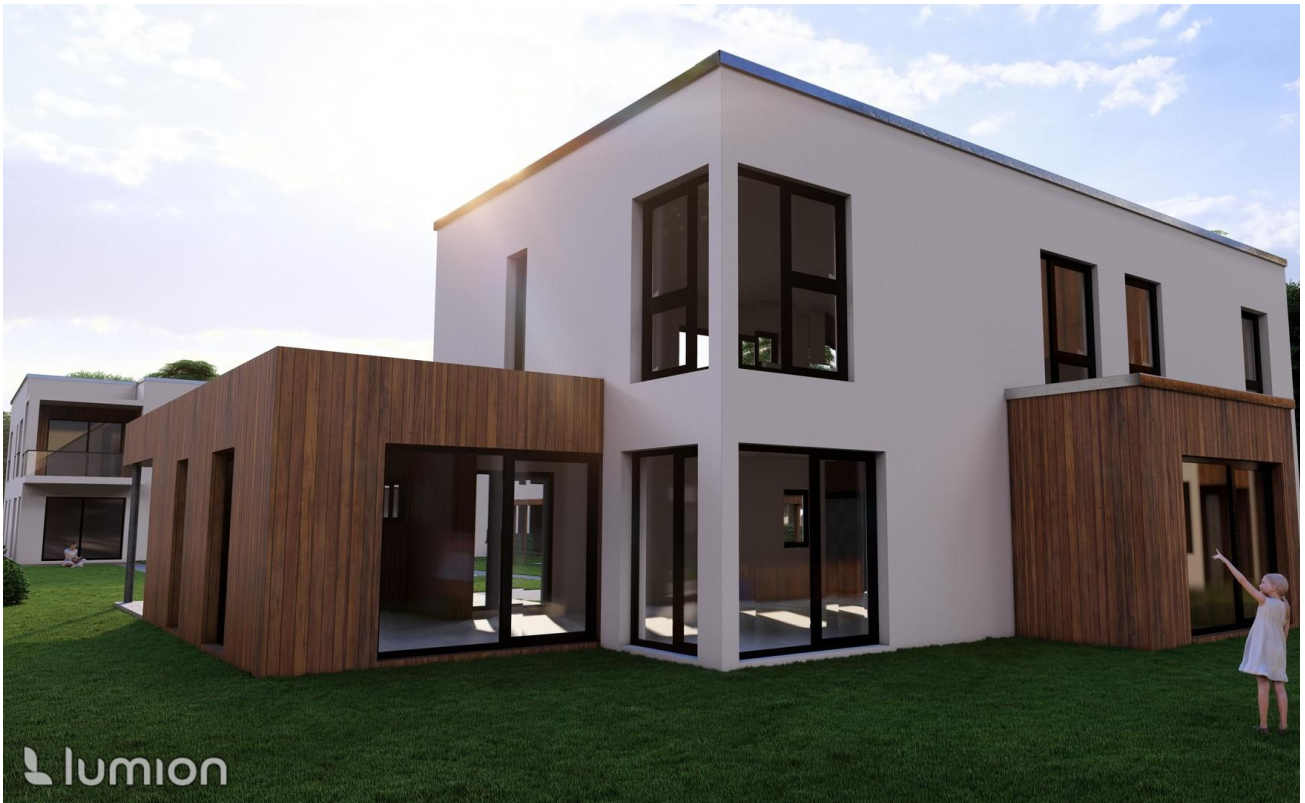
Doppelhaus 1 Ansicht Südwest
