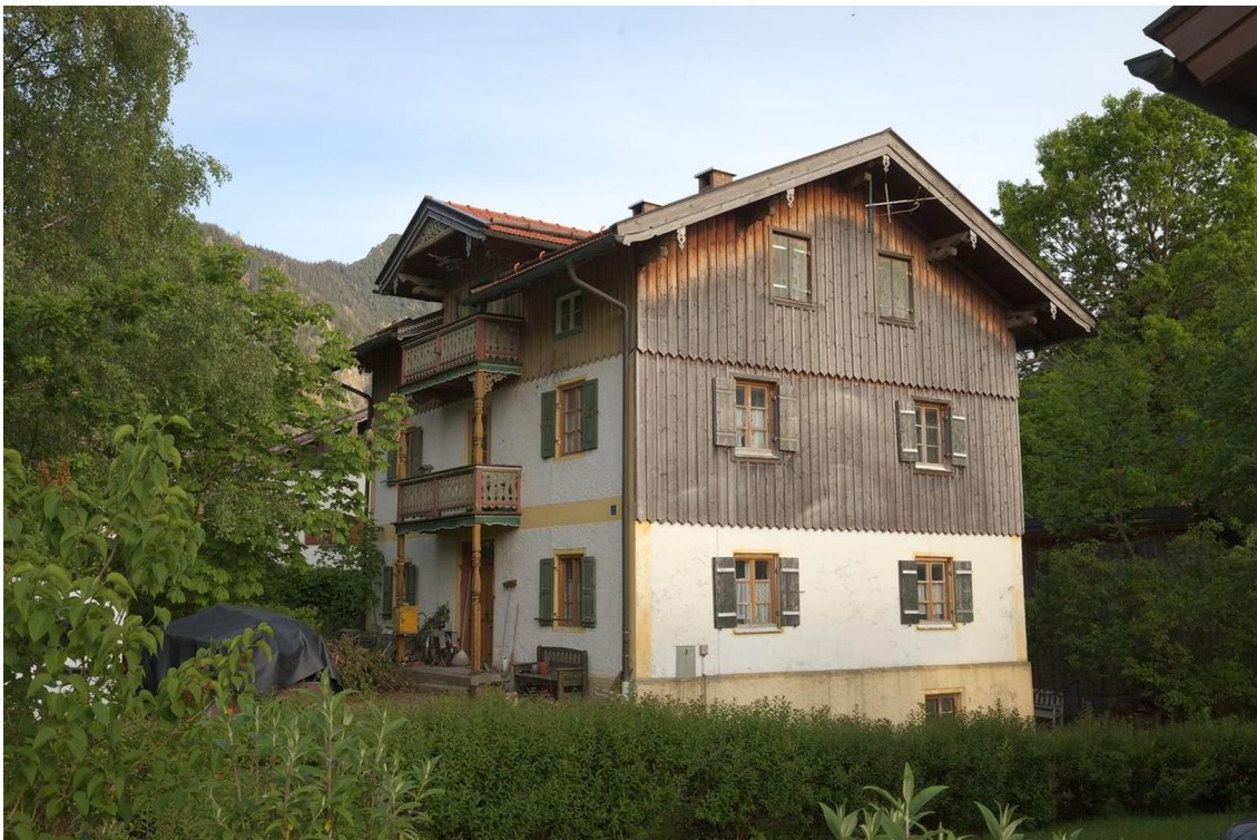
Von der Straße aus, Westseite
