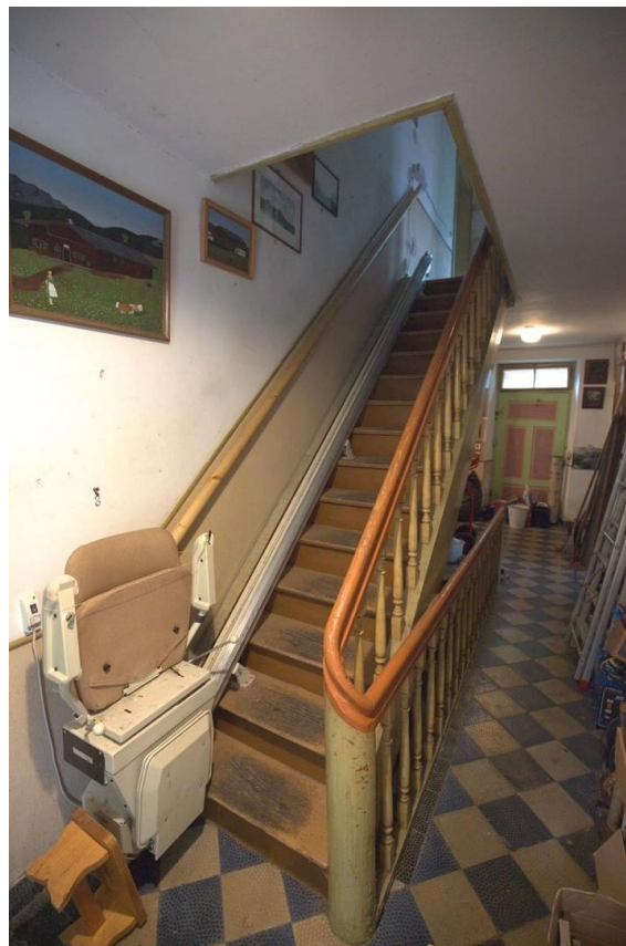
Flur und Treppenhaus im EG.
